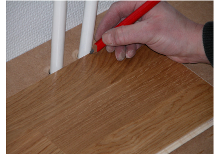
9: ...og hvor langt fra enden af brættet hullet skal være.
