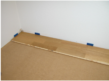
1: Afmål den første række af brædder ved at lægge dem ud uden at lime dem.
