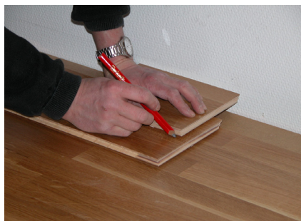
11: Den sidste række af brædder skal normalt skæres på langsiden. Med noten mod væggen, placer det sidste bræt ovenpå og kant mod kant med næstsidste bræt. Anbring et ekstra stykke bræt ovenpå og mål afstanden ved at trække brættestykket langs væggen og marker med en blyant hvor det sidste bræt skal skæres af.
