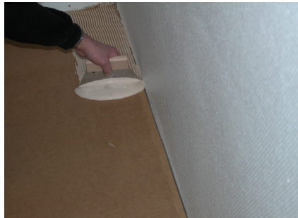
5: Fjern brædderne som du har lagt ud. Fordel lim på undergulvet hvor en hel række af brædder skal ligge. Læg brædderne ned en efter en op ad væggen. Sæt kiler mellem gulv og væg.
