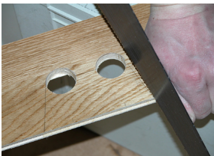
10: Sav det stykke af som sidder bag ved røret. Skær i en vinkel som vist på billedet. Hvis hullet er langs den korte ende af brættet, skær brættet i en vinkel på 90° lige igennem hullet. Læg lim og tryk brættet på plads, dæk med rørmanchetter.
