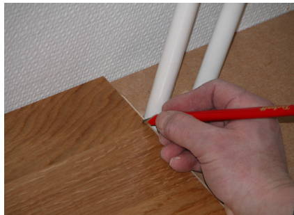
8: Rørgennemføringer på langsider: Bor et hul med en diameter på ca. 10 mm større end diameteren på røret. Mål hvor langt inde hullet skal bores...
